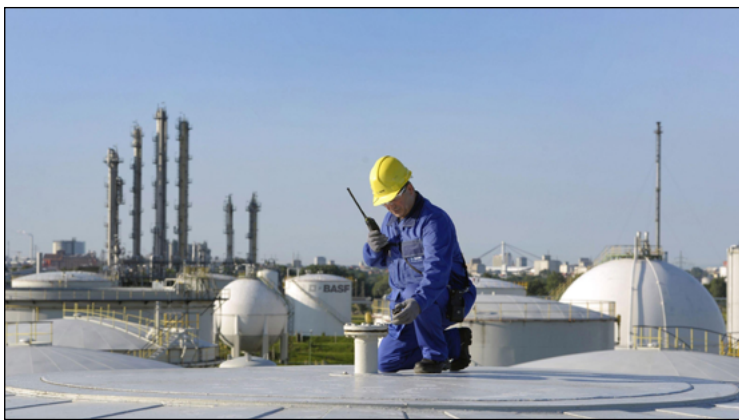
Am BASF-Verbundstandort Ludwigshafen prüft ein Mitarbeiter Dichtungen am Tank. Foto: BASF
