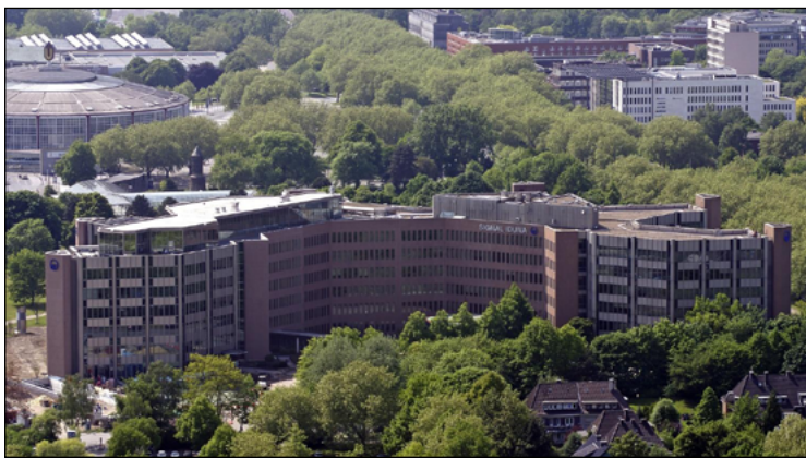
Alles im Blick dank IT: Signal Iduna, Hauptverwaltung in Dortmund. Foto: Signal Iduna
